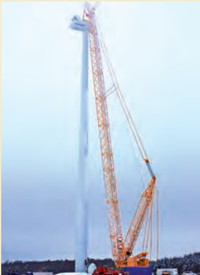
Bau eines Windrades im Windpark Weilmünster/Weinbach im Dezember 2010
